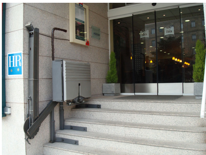
Plataforma de acceso para PMR
