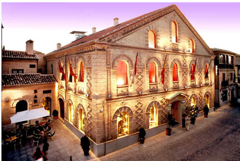
Fachada del hotel
