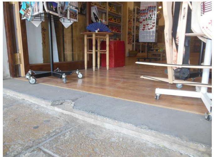
Escalón de entrada
