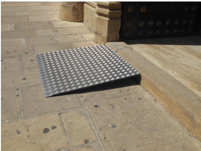
Rampa de acceso
