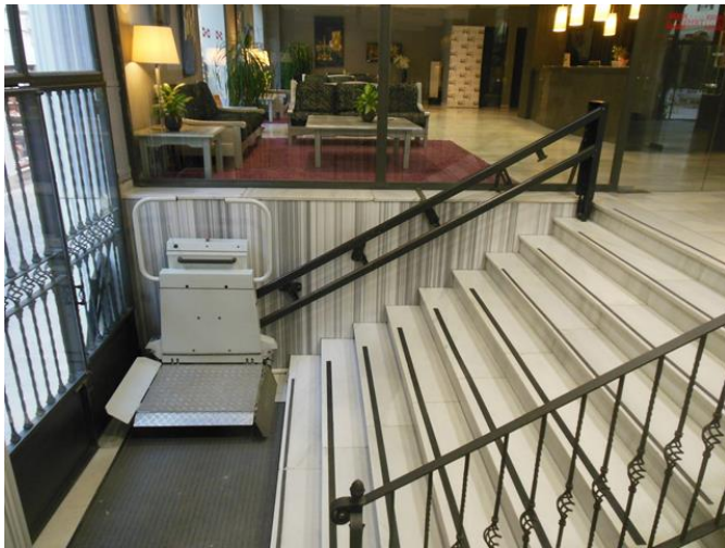
Escalera y plataforma salvaescaleras
