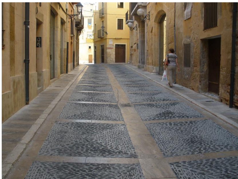
Calle de acceso
