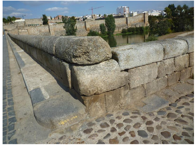
Detalle del puente
