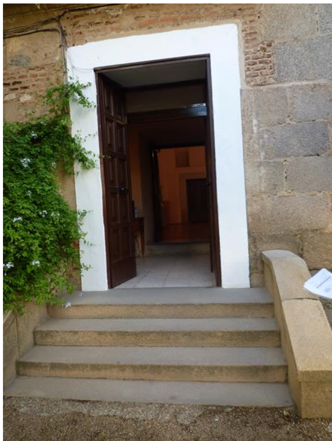
Escaleras de acceso
