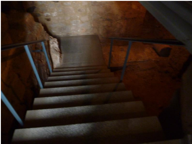
Escaleras de acceso a la cripta
