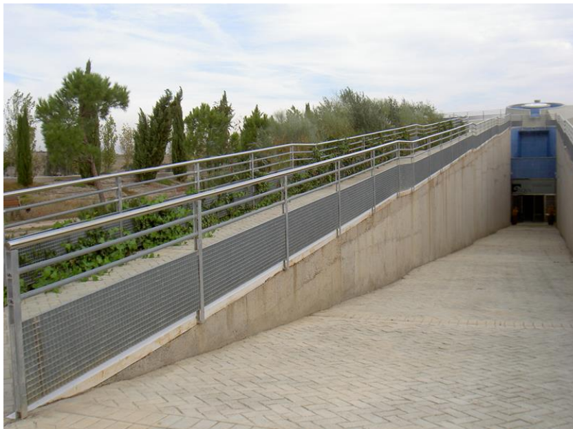
Rampa de acceso
