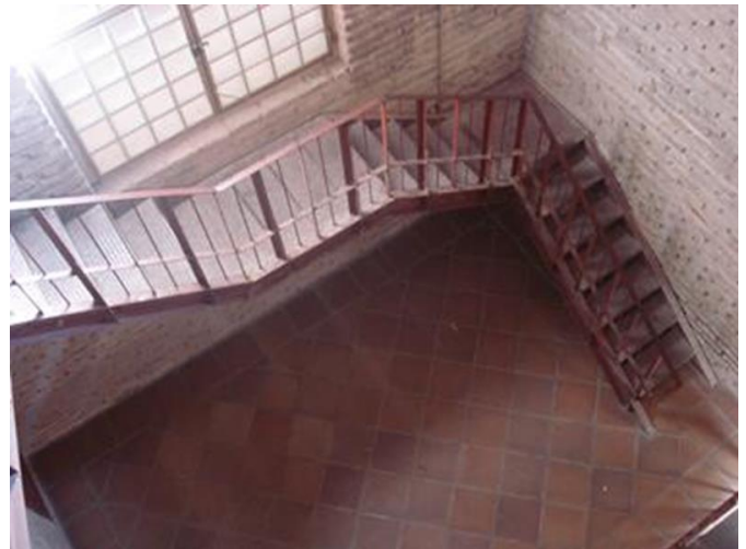
Escalera de acceso a las torres
