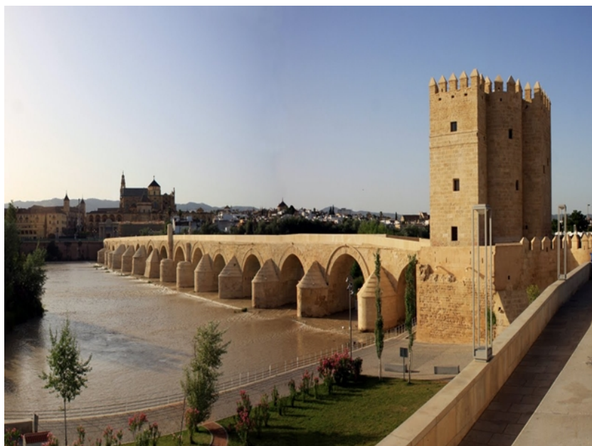
Vista lateral del puente
