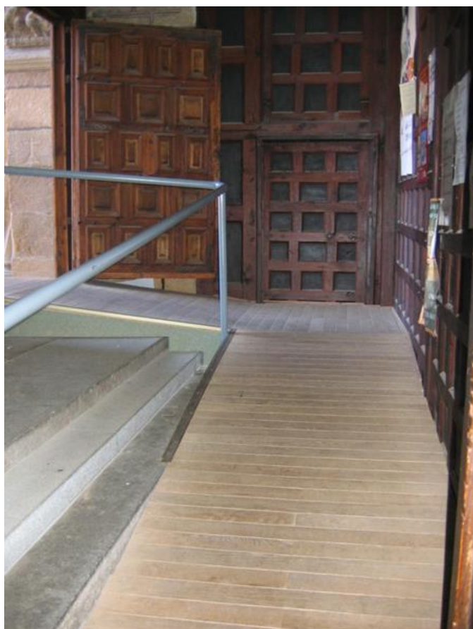
Rampa de acceso
