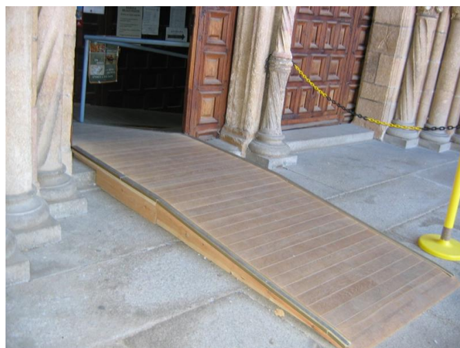
Rampa de acceso
