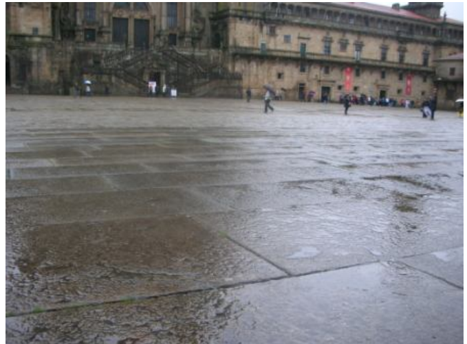
Pavimento Plaza del Obradoiro
