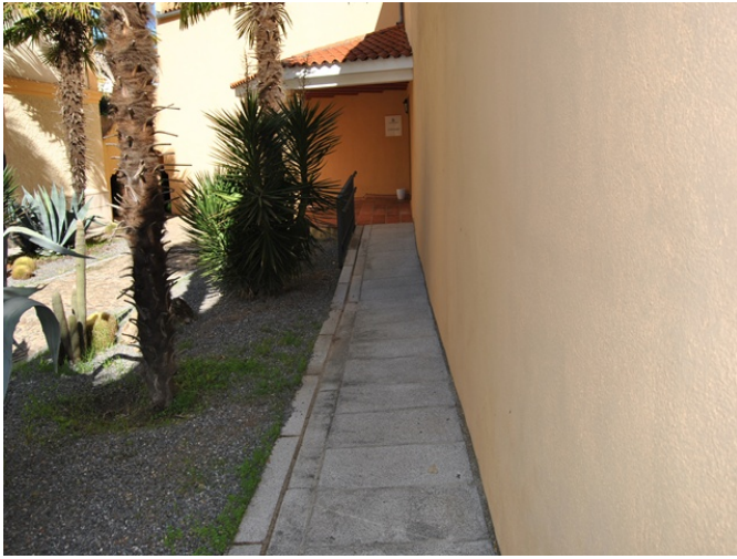
Rampa exterior de acceso al museo
