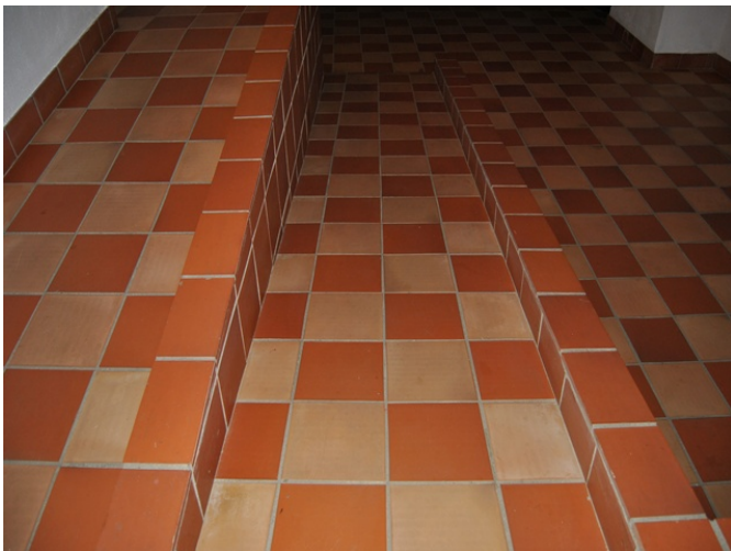
Rampas interiores de acceso al vestíbulo
