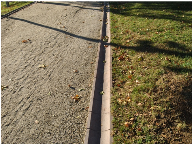
Bordillo lateral de separación de zona verde
