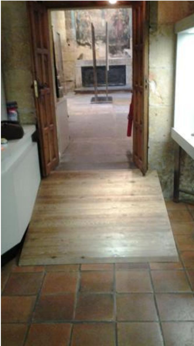
Rampa de acceso al mostrador de recepción.
