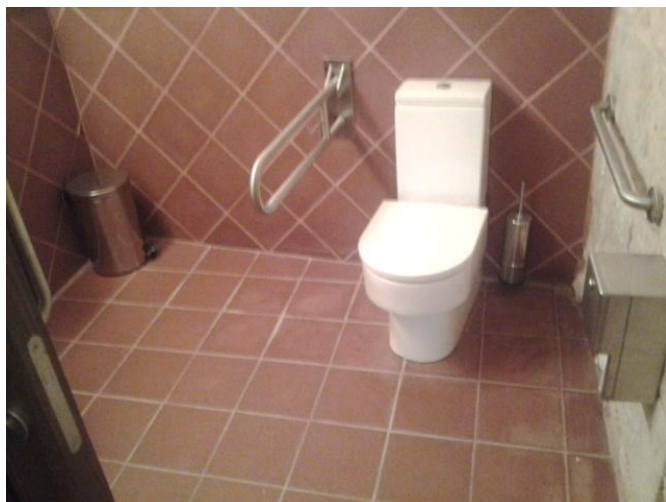
Cabina de aseo para PMR.
