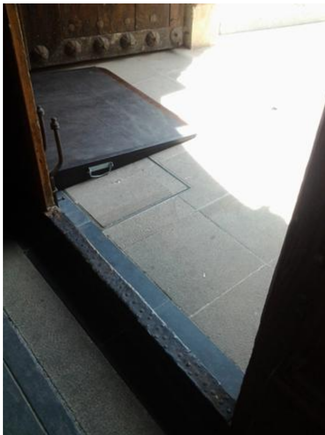
Acceso con rampa portátil.
