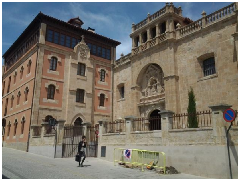
Calle de acceso y fachada del edificio.
