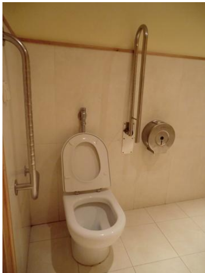
Aseo adaptado para PMR
