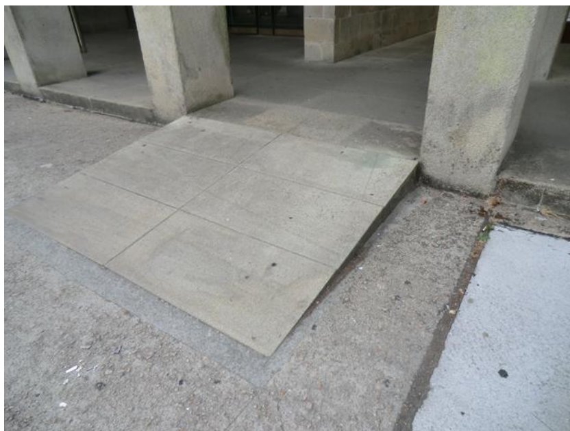
Rampa de acceso al interior del restaurante
