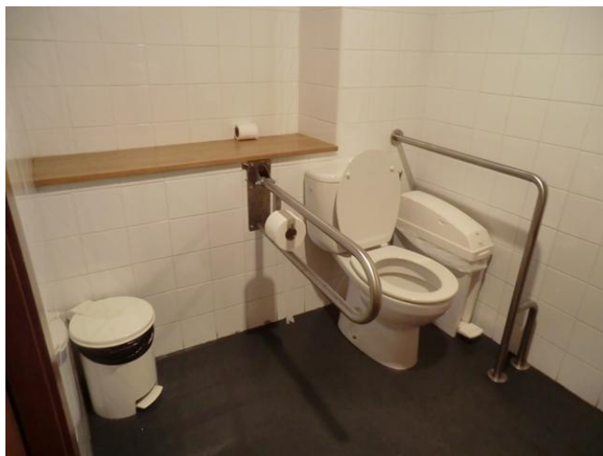
Aseo adaptado para PMR
