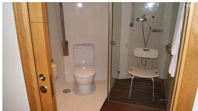
Cuarto de baño de la habitación adaptada: inodoro y ducha con barras de apoyo y silla homologada
